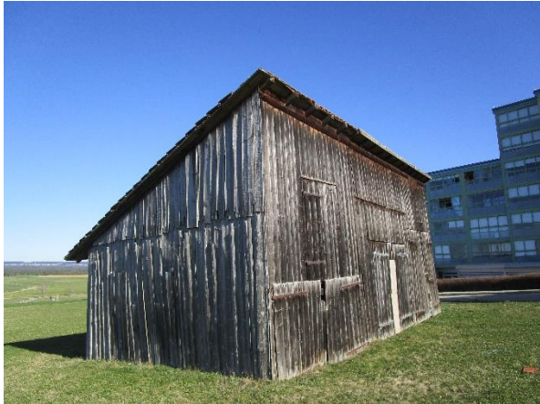
Weiterer Schuppen im Plangebiet.
