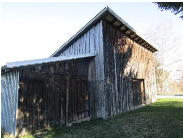
Schuppen im Plangebiet.
