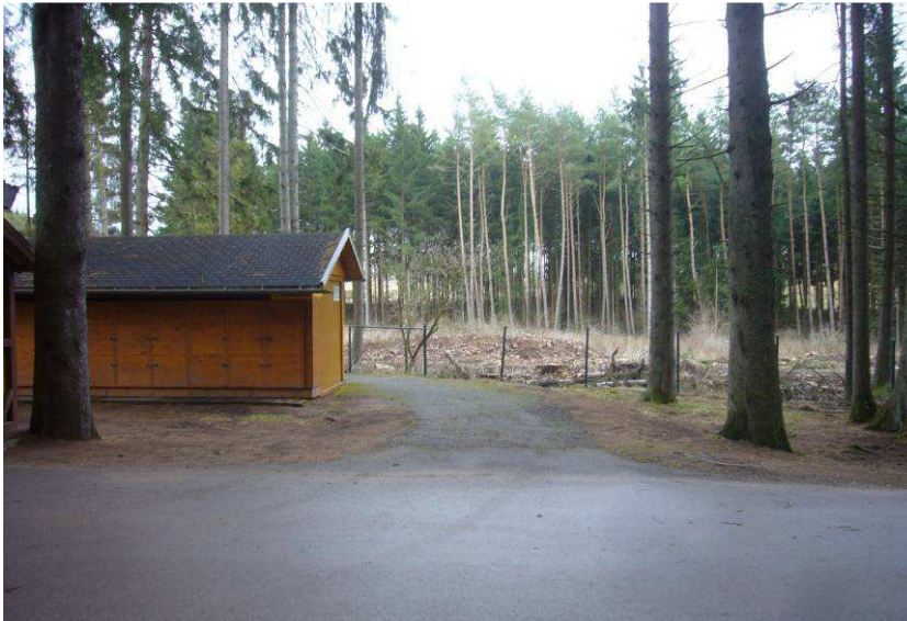
Foto 3: Zufahrt zur Heizzentrale
