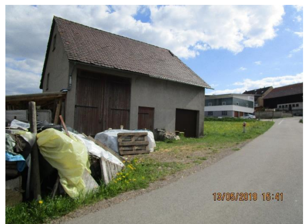
Abb. 7: Gebäude aus Abb. 5 von der Straße aus gesehen.
