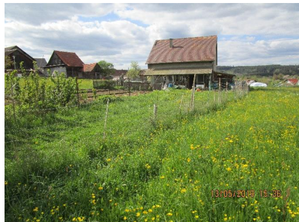
Abb. 16: Altes Gebäude mit angrenzendem Gartengrundstück.
