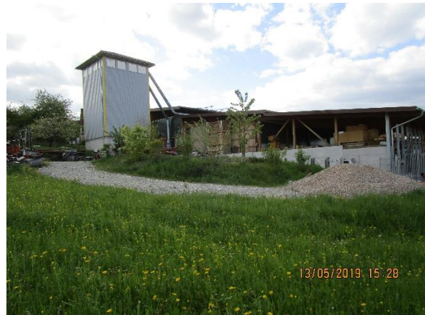
Abb. 20: Außenbereich des Zimmereibetriebs.
