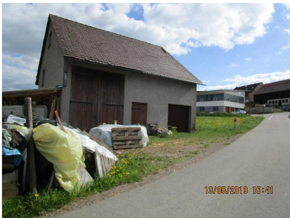
Abb. 15: Altes Gebäude (Front) mit Plangebiet mit potentiellen Habitatstrukturen für Gebäudebrüter und Fledermäuse
